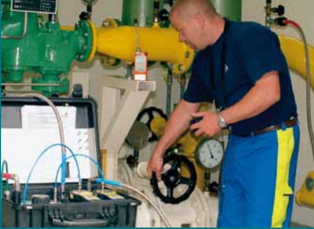
Funktionsprüfung durch Rohrnetzmonteur
