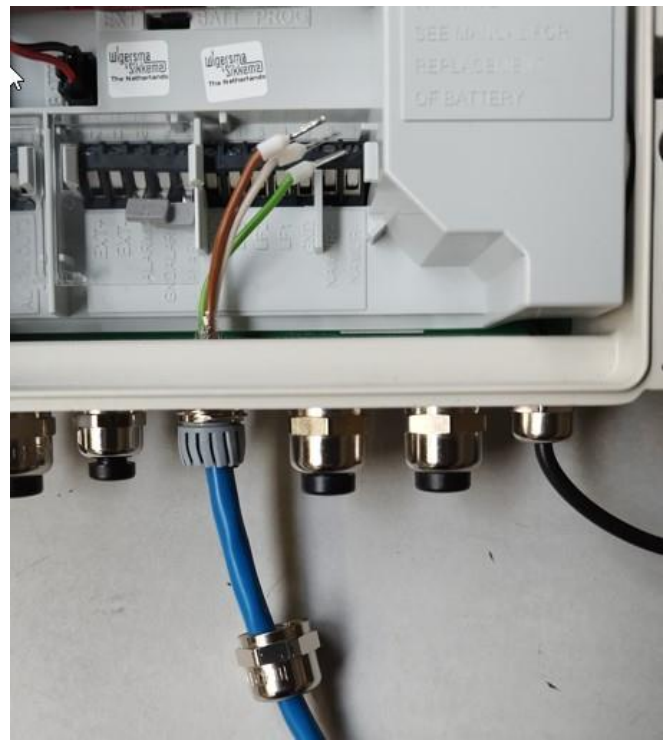
8: Druk de afdichthuls in de kabeldoorvoerwartel en draai deze enigszins vast.
