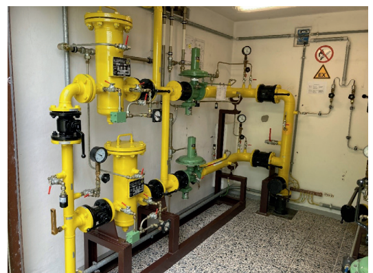
Bild 3: Mitteldruckstation-GDRA
